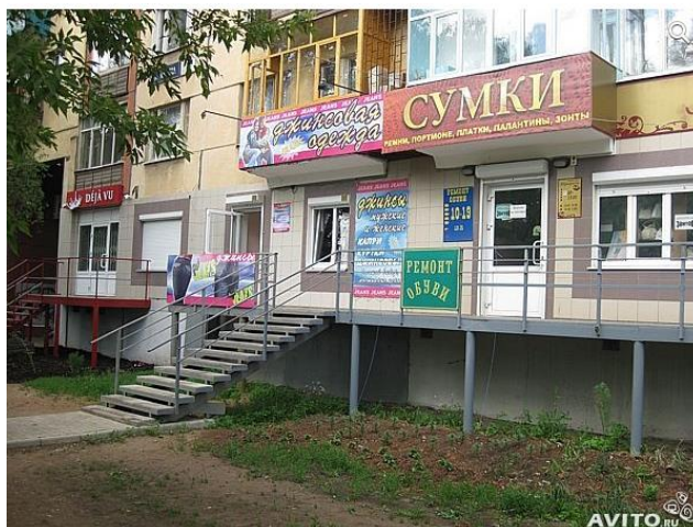
Рис. Встроенное помещение на 1-ом этаже жилого дома (бывший жилой фонд)
