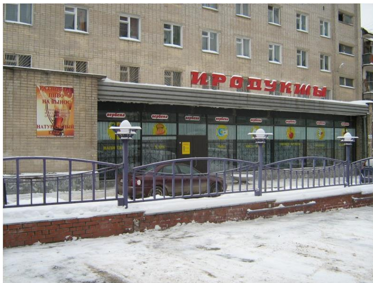
Рис. Встроенно-пристроенное торговое помещение
